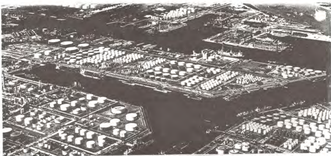
รูปที่ 1 ลานถัง (tank farm) ปกติจะเห็นอยู่ริมทะเล หรือริมแม่น้ำเพื่อสะดวกต่อการขนส่ง
