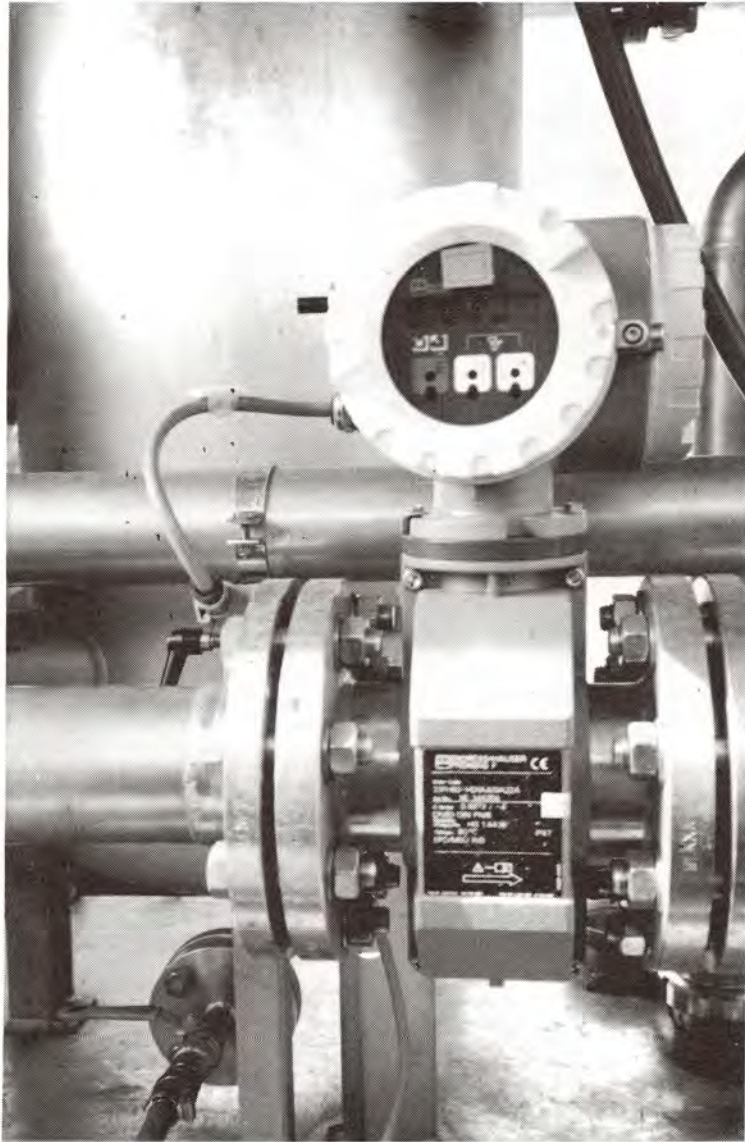
รูปที่ 86 มาตรวัดแบบมาตราชนิด Magnetic flowmeter ขนาด \varnothing 3 นิ้ว Max. flow 850 l/min
