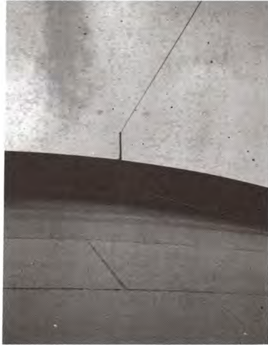
รูปที่ 104 ชุดรอกซึ่งติดตั้งอยู่บนผนังชั้นบนสุดเพื่อให้เจ้าหน้าที่ลากชุด movable scale assembly ขึ้นลงตามผนังได้ เพื่อประสานงานได้อย่างใกล้ชิดกับเจ้าหน้าที่อีกคนหนึ่งซึ่งกำลังส่องกล้องอ่านค่า
