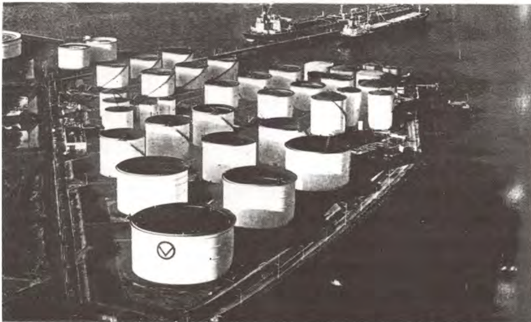
รูปที่ 67 บริเวณลานถัง (tank farm) พร้อมกับท่าเทียบเรือ (jetty) เพื่อการขนถ่าย
